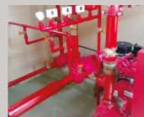
PROJETOS E OBRAS DE COMBATE A INCÊNDIO
