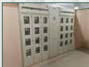
PC de luz reformado atendendo às normas da Light.
