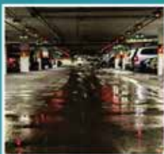
IMPERMEABILIZAÇÃO DE GARAGENS
