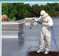
IMPERMEABILIZAÇÃO COM POLIUREIA
