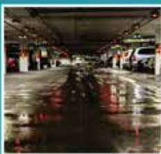
IMPERMEABILIZAÇÃO DE GARAGENS
