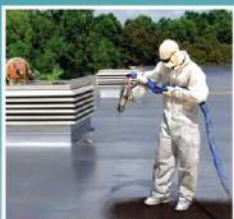
IMPERMEABILIZAÇÃO COM POLIURÉIA
