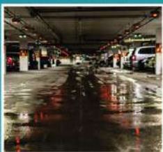
IMPERMEABILIZAÇÃO DE GARAGENS
