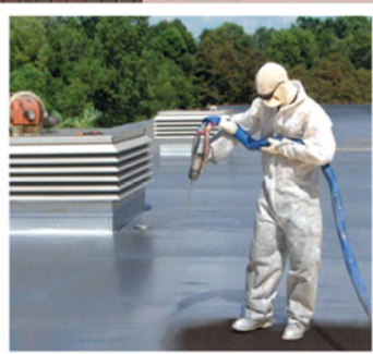
IMPERMEABILIZAÇÃO COM POLIUREIA
